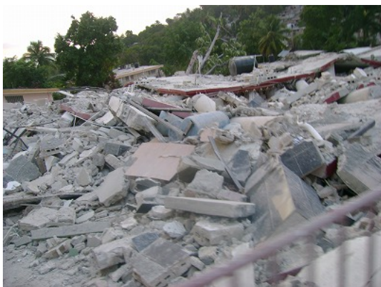
多くの建物が破壊された
